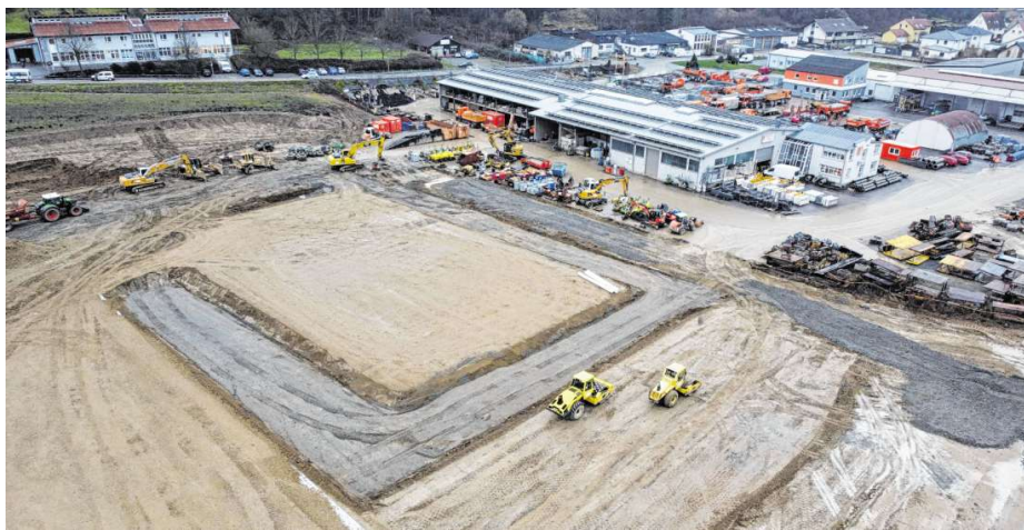
Die Erdarbeiten für die umstrittene Bodenaufbereitungsanlage der Firma Konrad Bau im Gerlachsheimer Gewerbegebiet „Plützenacker“ haben begonnen. BILD: OLIVIER LUKSCH
