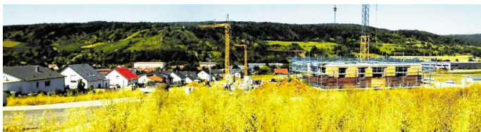
Gleich vier Baustellen in einer Straße – die Firma Deeg hat hier gut zu tun.
