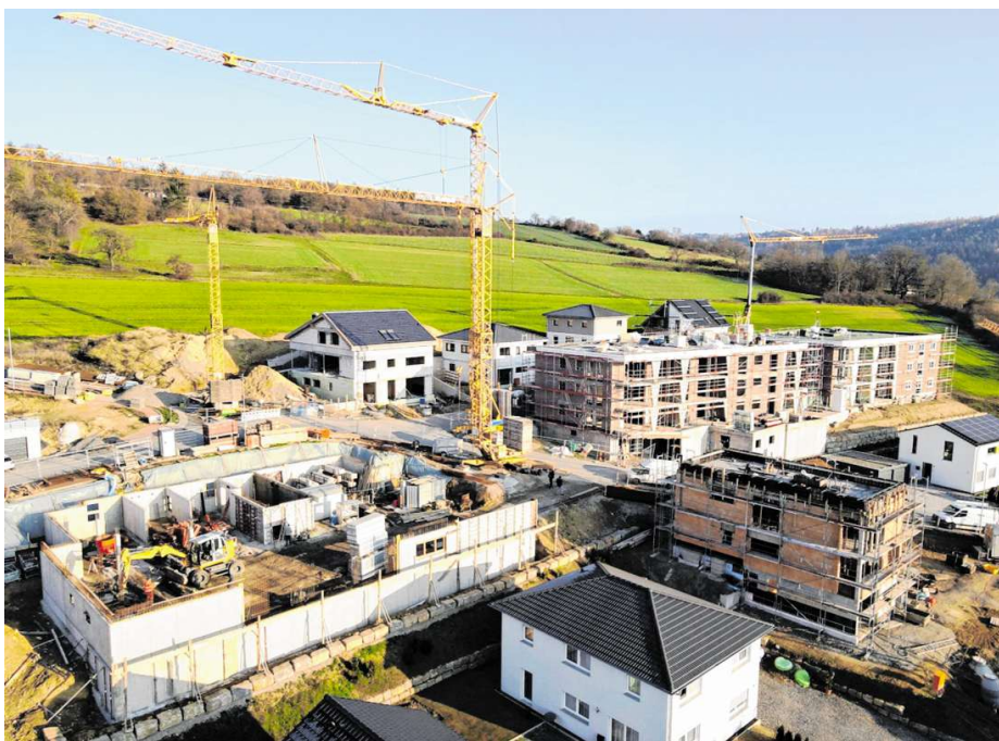
Für die Baufirma Stumpf gibt es viel zu tun.
